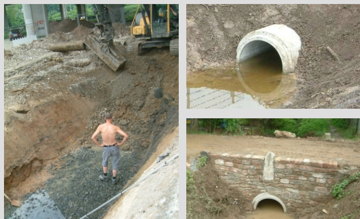
Sanierung von Durchlässen
